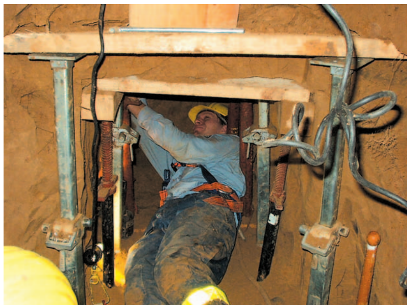
Verstreben des Stollens mit Grabenstützen durch THW-Helfer der Fachgruppe Bergung. (Bild 2)
