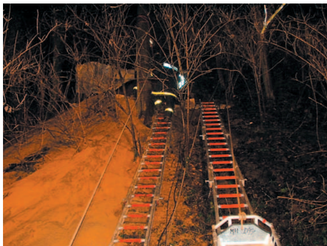
„Aufstieg“ zur Einsatzstelle. Der helle Sand ist der Aushub, welcher bereits aus dem Stollen gegraben wurde. (Bild 1)
