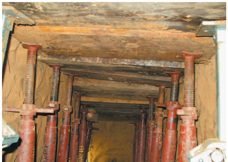
Abstützung der zugeschnittenen Bohlen durch die Grabenstützen der Feuerwehr und des THW. (Bild 4)
