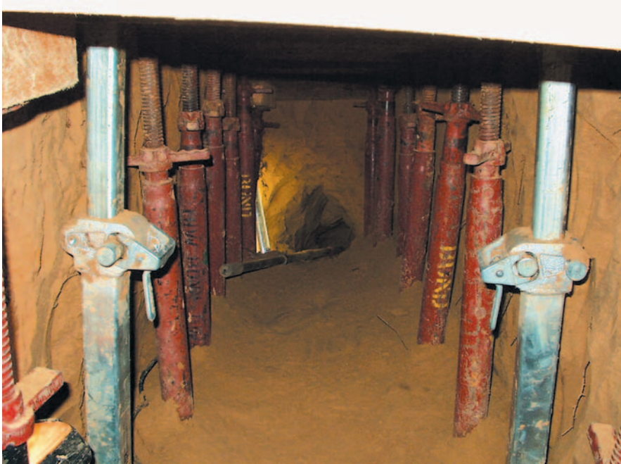
Rettungsstollen nach beendeter Tierrettung. In der Tunnelröhre befindet sich noch die Tierfangschlinge. (Bild 5)
