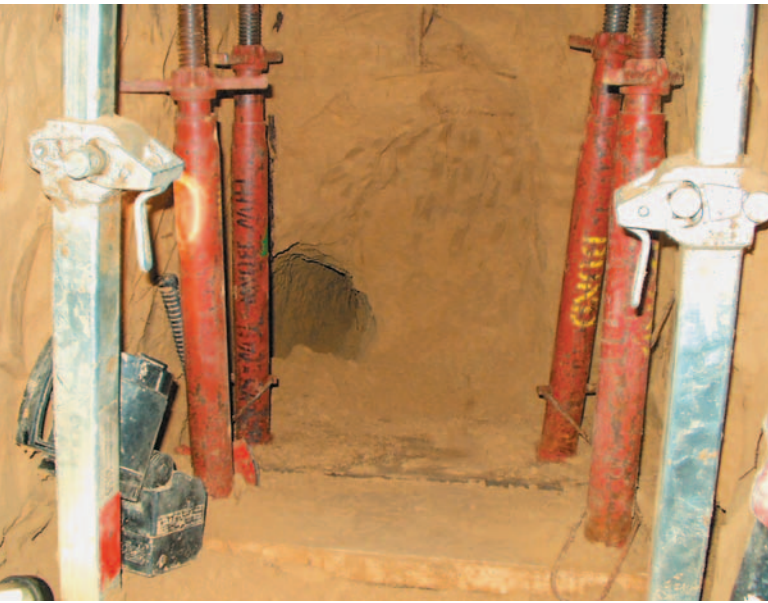
Eingebaute Grabenstützen im Stollen. Links ist der freigegrabene Bereich des Röhrensystems zu erkennen. (Bild 3)
