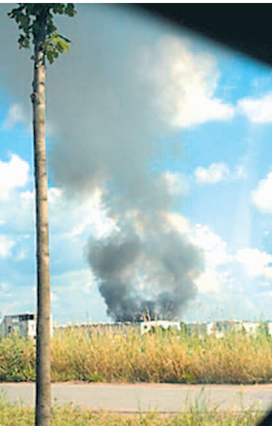
Bild 6: Großbrand einer Industriehalle in der Stadt Troisdorf
