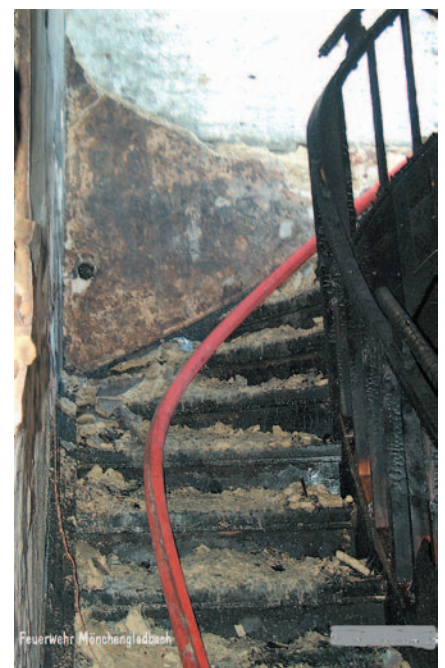
Bilder 8 und 9: Treppenraum
