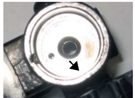
Bild 5: Mechanische Verformung des Druckminderergehäuses am Sicherungsring des Steuerkolbens.
