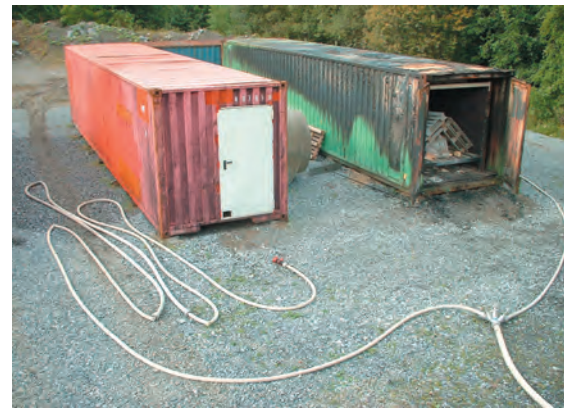
Ansicht der Wärmegewöhnungsanlage mit Brandstelle.
