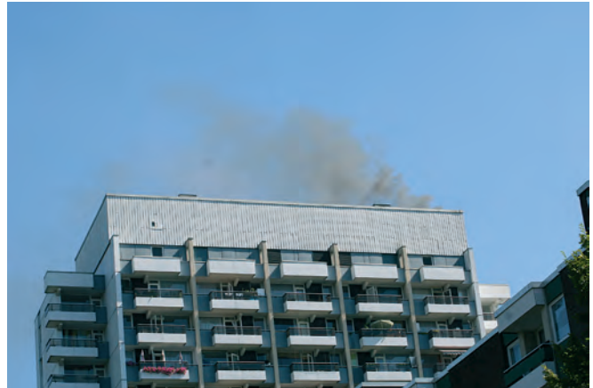
Abb. 3: Gebäudeansicht auf der Anfahrt. Die Brandausbruchsstelle liegt rechts auf dem Balkon, die betroffenen Räume auf der abgewandten Seite
