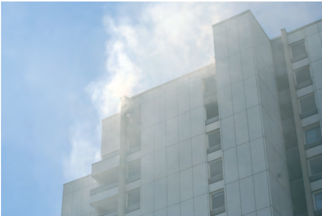
Abb. 4: Ansicht des Brandgeschosses von der Gebäudefront
