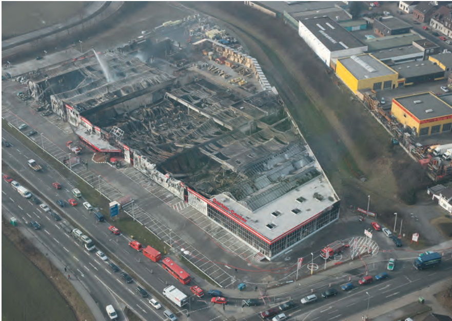
Luftaufnahme am Tag nach dem Großbrand
