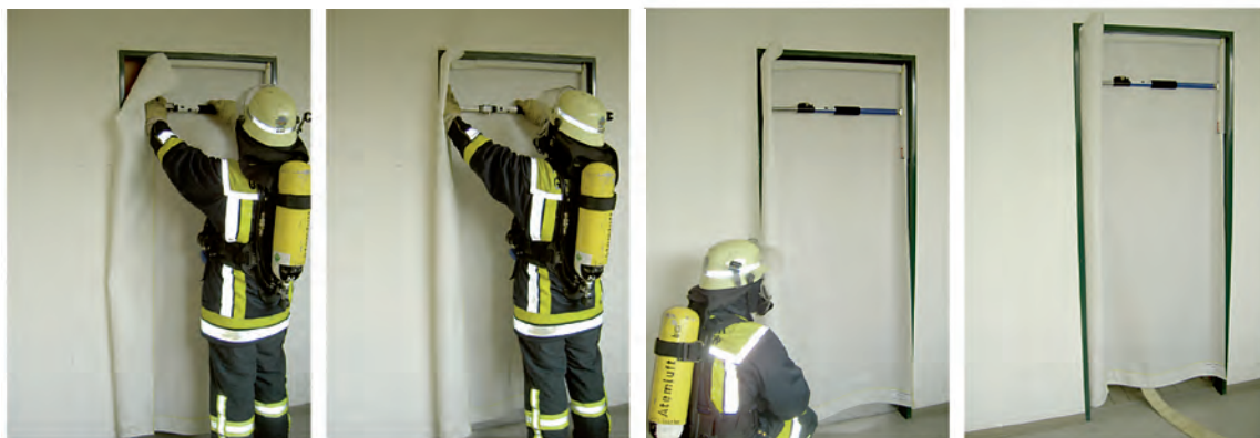
Einbau des mobilen Rauchverschlusses in eine einflügelige Tür, die in Angriffsrichtung aufschlägt
