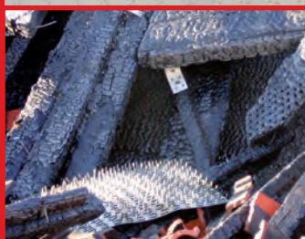
Nagelplattenbinder bergen hohes Risiko für die Feuerwehr
