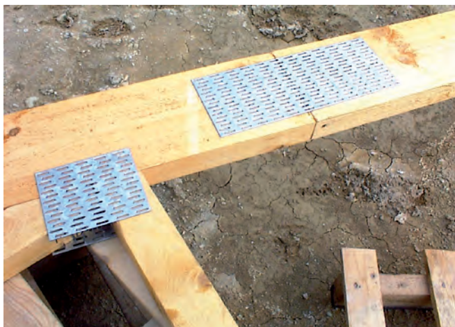
Bild 1: Nagelplattenverbindungen.
