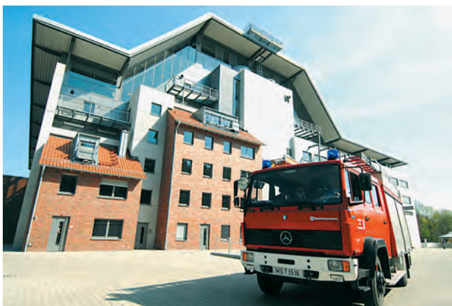
Die Rückansicht der neuen Übungshalle.
