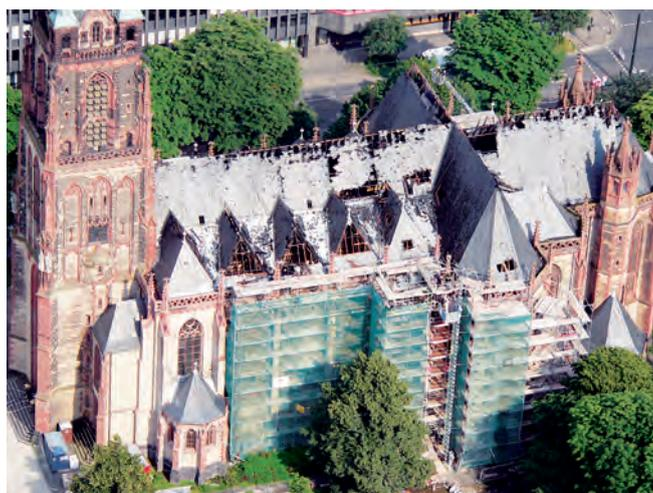
Der ausgebrannte Dachstuhl in der Gesamtübersicht. Das Feuer entstand am Fuß des Daches zwischen dem zweiten und dritten Seitengiebel.
