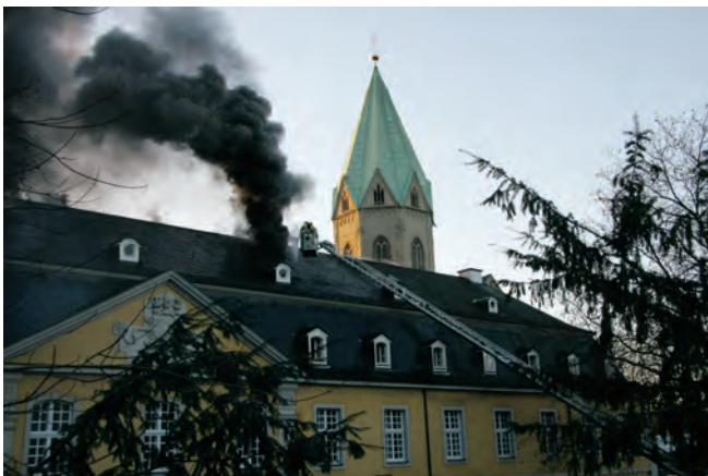
Öffnen der Dachhaut.
