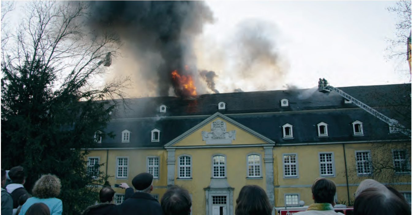
Das Dach brennt durch.
