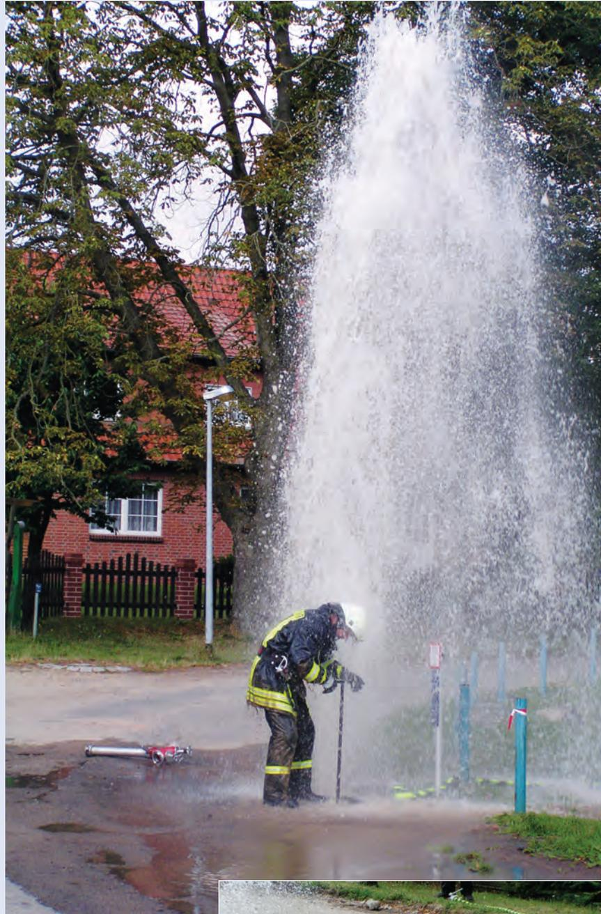
*Gefahr durch ein herumfliegendes Standrohr.
