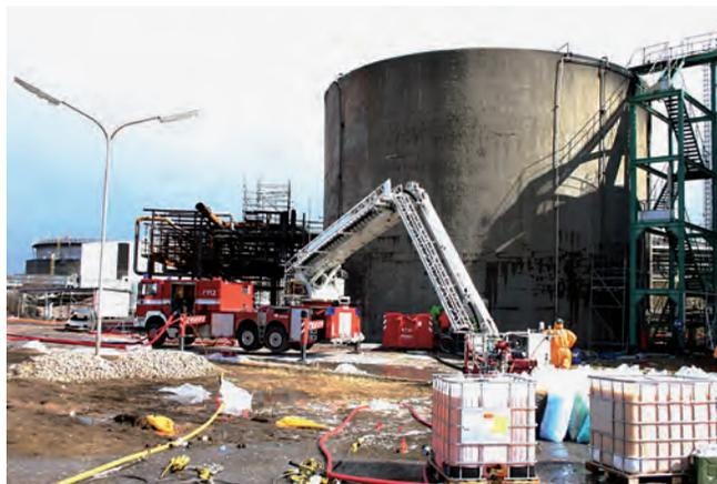
Umpump- und Sicherungsarbeiten am abgelöschten Chemikaliertank
