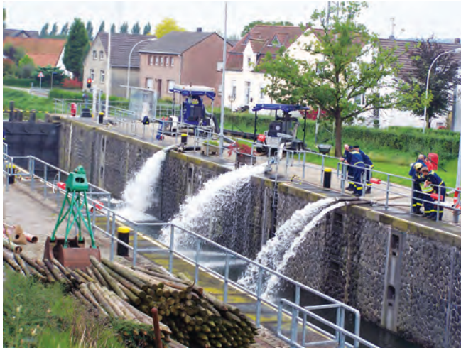
Befüllen der Schleusenammer in Wardhausen durch das THW [Quelle: THW].
