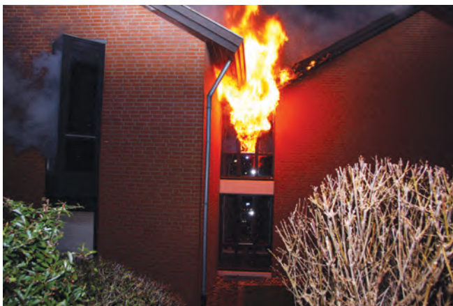
Lage kurze nach Eintreffen, Flammen schlagen aus dem Fenster des Flurs. Links ein Fenster der betroffenen Wohnung (austretender Brandrauch).
