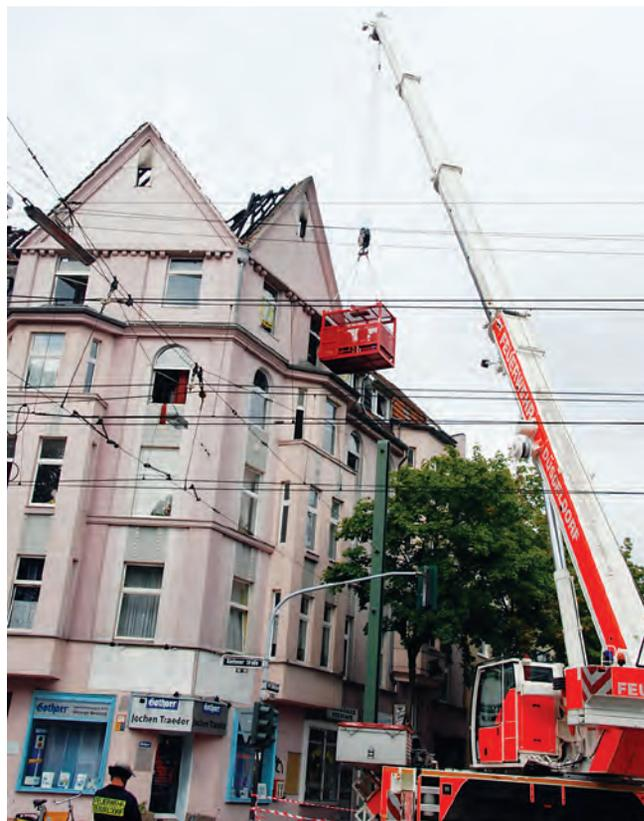
Mittels Kran und Arbeitskorb erfolgte der Materialtransport in die betroffenen Räume. Um Kommunikationsprobleme zu vermeiden, wurden die Fenster der Räume durchnummeriert
