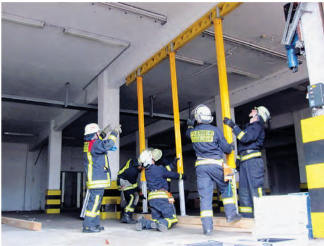
Abstützung eines Unterzuges, mittels "Multiprob"-Schnellbaustützen.
