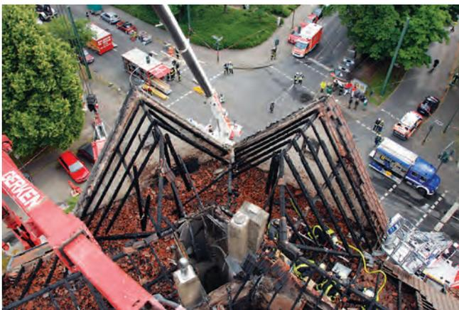
Ein Blick auf den zerstörten Dachstuhl: Zu erkennen sind die freistehenden Giebelwände sowie die freistehenden Kamine.
