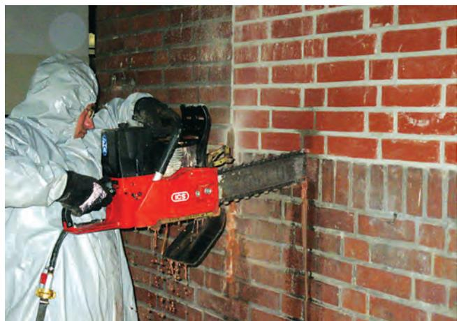
Einsatz einer Beton-Motorkettensäge, um verdeckte Hohlräume zu kontrollieren.
