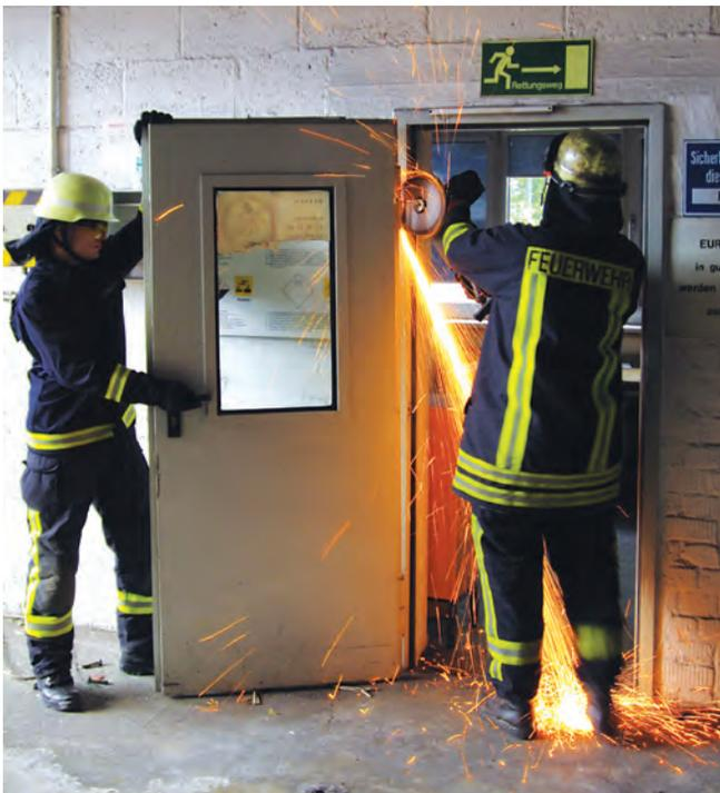
Heraustrennen einer Stahltür mittels Winkelschleifer, um weitere Arbeiten zu erleichtern.
