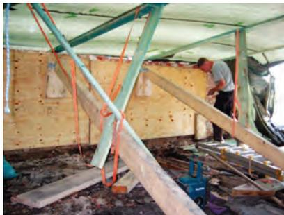
*Klebetechnik: Verbundholzplatten wurden mittels PU-Schaum an die innenliegende Seite der Giebelwände geklebt. Zur Stabilisierung wurden diese anschließend mit Holzbohlen abgestützt.*
