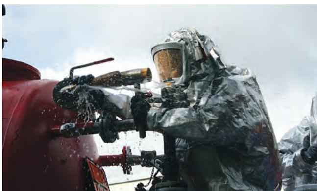
*Abdichten einer Abgerissenen Rohrleitung unter Vollschutz.*
