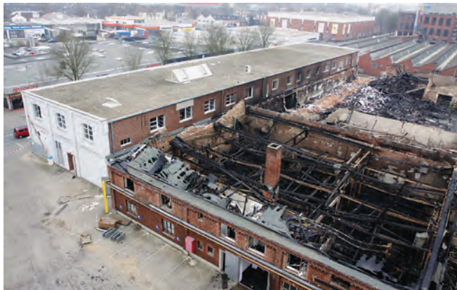
Übersichtsaufnahme (links): Blickrichtung auf das zweigeschössige Gebäude. Übersichtsaufnahme (rechts): Angrenzende nördliche Lagerhalle. Erkennbar sind die Auswirkungen der Wärmestrahlung auf die angrenzende Dachfläche.
