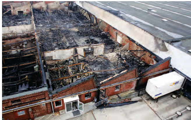
Übersichtsaufnahme (links): Blickrichtung auf das zweigeschössige Gebäude. Übersichtsaufnahme (rechts): Angrenzende nördliche Lagerhalle. Erkennbar sind die Auswirkungen der Wärmestrahlung auf die angrenzende Dachfläche.
