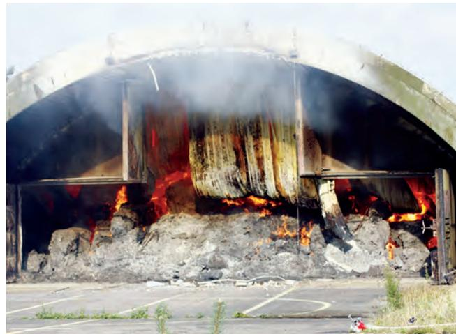
die im Frontbereich herabhängenden und so wie ein Vorhang wirkenden Trapezbleche der Innenverkleidung entfernt werden.
