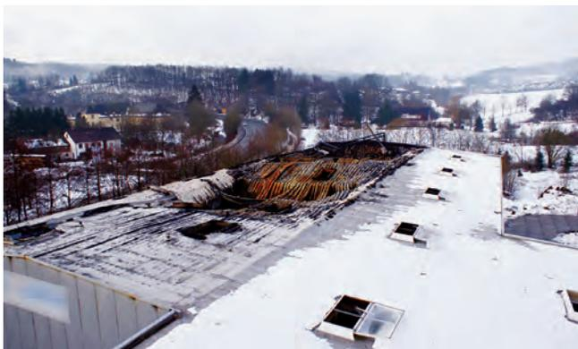
Um 09.45 Uhr ist das Feuer weitestgehend erloschen, das Dach ist zwischenzeitlich eingestürzt und liegt auf der Kranbahn.
