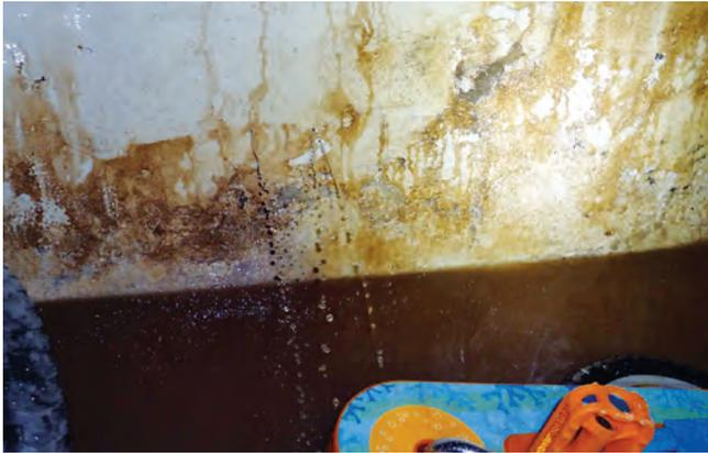
*Auf die Grundmauern des Gebäudes lastete ein enormer Wasserdruck. Das Wasser drang aus den Grundmauern im Keller aus.*
