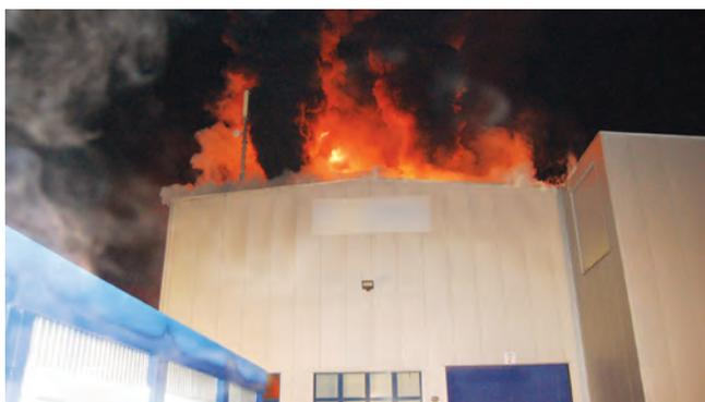
Blick auf die Produktionshalle gegen 06.00 Uhr aus östlicher Richtung. Im vorderen Teil ist deutlich die Wirkung der Rauch- und Wärmeabzüge zu erkennen.
