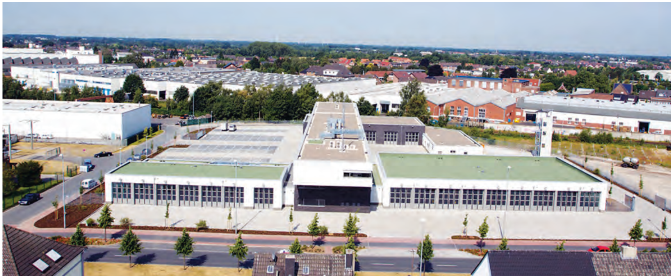
Die 1.000 m 2 große Fahrzeughalle für den Brandschutz sowie die Rettungswache mit einer Fläche von 632 m 2
