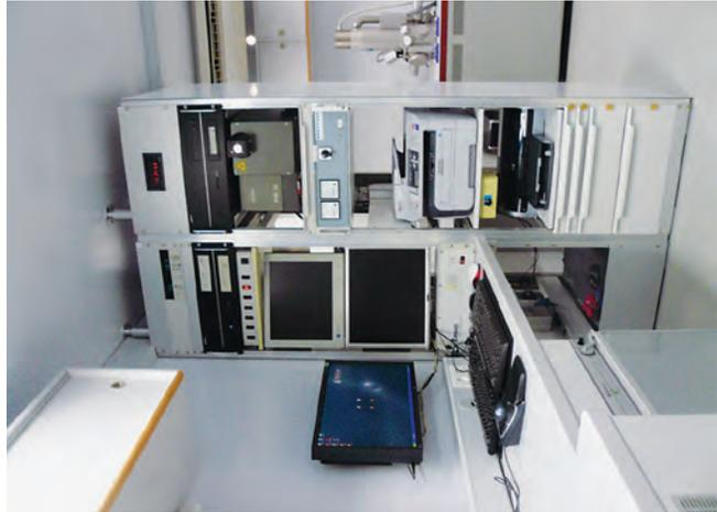
Im mittleren Teil sind die kontinuierlich registrierenden Messgeräte, Sensorgeräte, Prüfröhrchen, Rechner, Akkus, die gesamte Stromtechnik, Arbeitstische sowie viele weitere Ausrüstungsgegenstände untergebracht.
