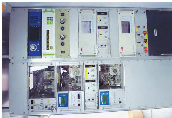
Über die Messgeräte werden u. a. kontinuierlich die Komponenten Kohlenmonoxid (CO), Stickoxide (NO, NO<sub>2</sub>) Schwefeldioxid (SO<sub>2</sub>), Salzsäure (HCl) und Ammoniak (NH<sub>3</sub>) ausgewertet.
