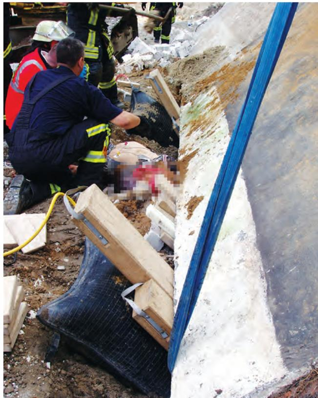
Abb. 3: Mittels Hebekissen und Unterbauung wurde Überlebensraum für den Patienten geschaffen. Im Vordergrund die Bandschlinge des Baggers. Foto: Feuerwehr Düsseldorf
