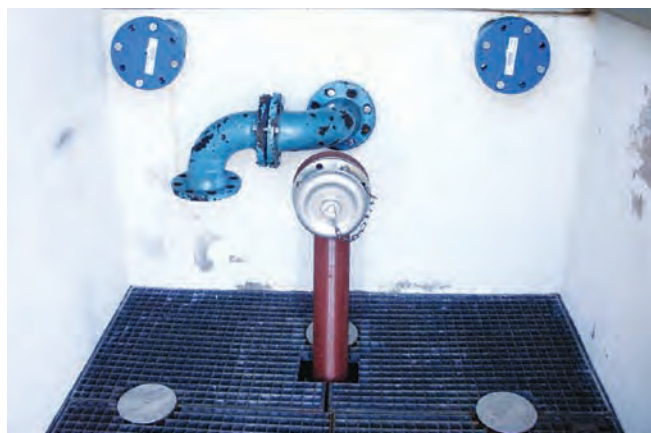
Der Energieversorger baute den Trinkwasserbehälter zum Löschwasserbehälter um.
