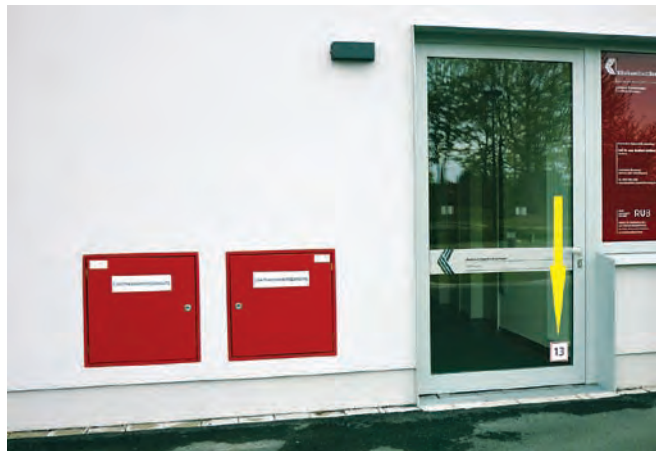
Wie auf dem Foto zu erkennen (gelber Pfeil), ist der Zugang Nummer 13 klar und unmissverständlich durch die Nummerierung auf der Tür von Einsatzkräften zu erkennen.
