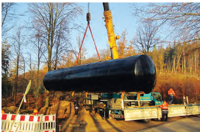
Anlieferung mit einem Tieflader und Kranentladung in die vorbereitete Baugrube des 12 m langen Löschwassertanks am 17.11.2011 im Waldgebiet "Hinnenwiese." Foto Feuerwehr
