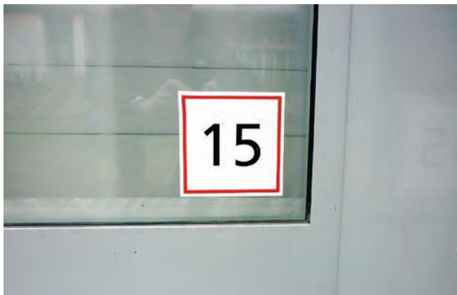
Die Aufkleber zur Kennzeichnung haben eine Größe von ca. 15 cm x 15 cm und sind somit auch schon von Weitem bei der Erkundung gut sichtbar.
