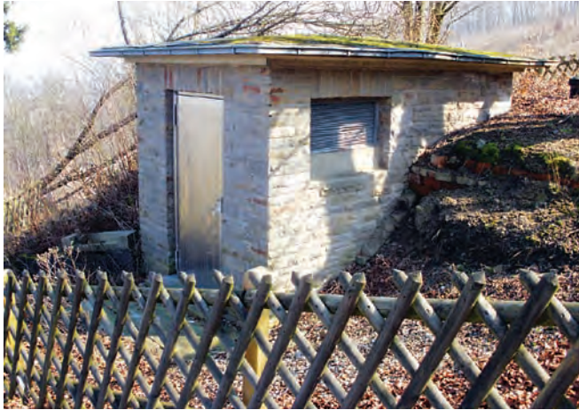
Ein eher unscheinbares Sandsteinbauwerk mit fast 50 m 3 Löschwasser hoch oben über der Stadt.
