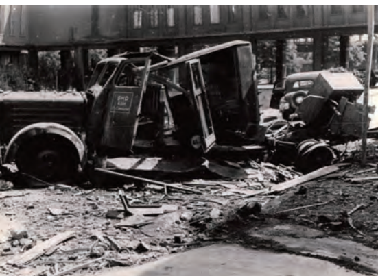
Durch einen Bombentreffer zerstörte KS 25 1942 (BF Köln)
