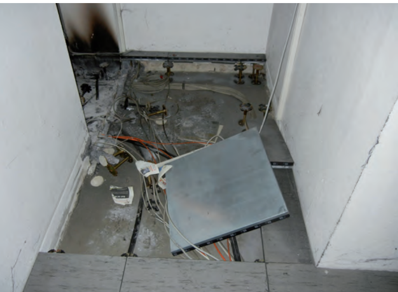
Die Systemböden mussten kontrolliert werden, um eine Brandausbreitung über die Hohlräume auszuschließen.
